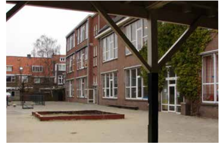
huidige achtergevel met kunststof kozijnen
